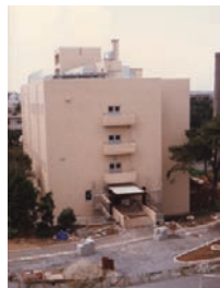
竣工当時の動物実験施設(1982年) Laboratory Animal Center at time of completion (1982)
