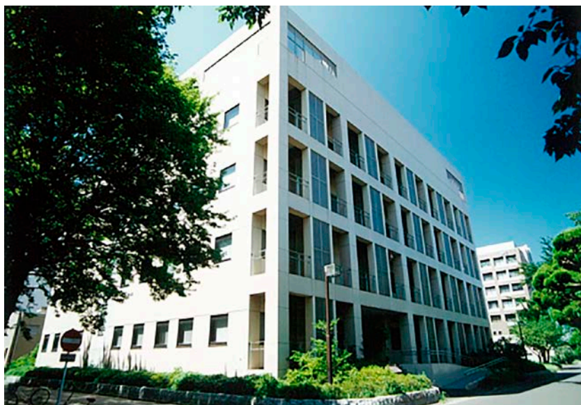
写真2-18-24-1 アイソトープ実験施設の建屋
