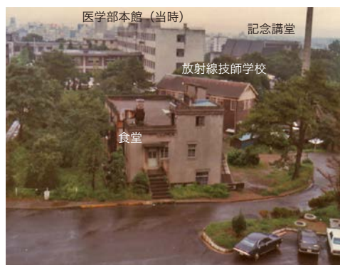
写真1-4-3-1 動物実験施設建設前の様子：食堂の位置に動物実験施設が建設された。
